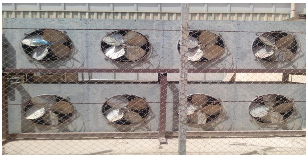
Fig.IV.4. Ventilateurs du groupe réfrigérant.
